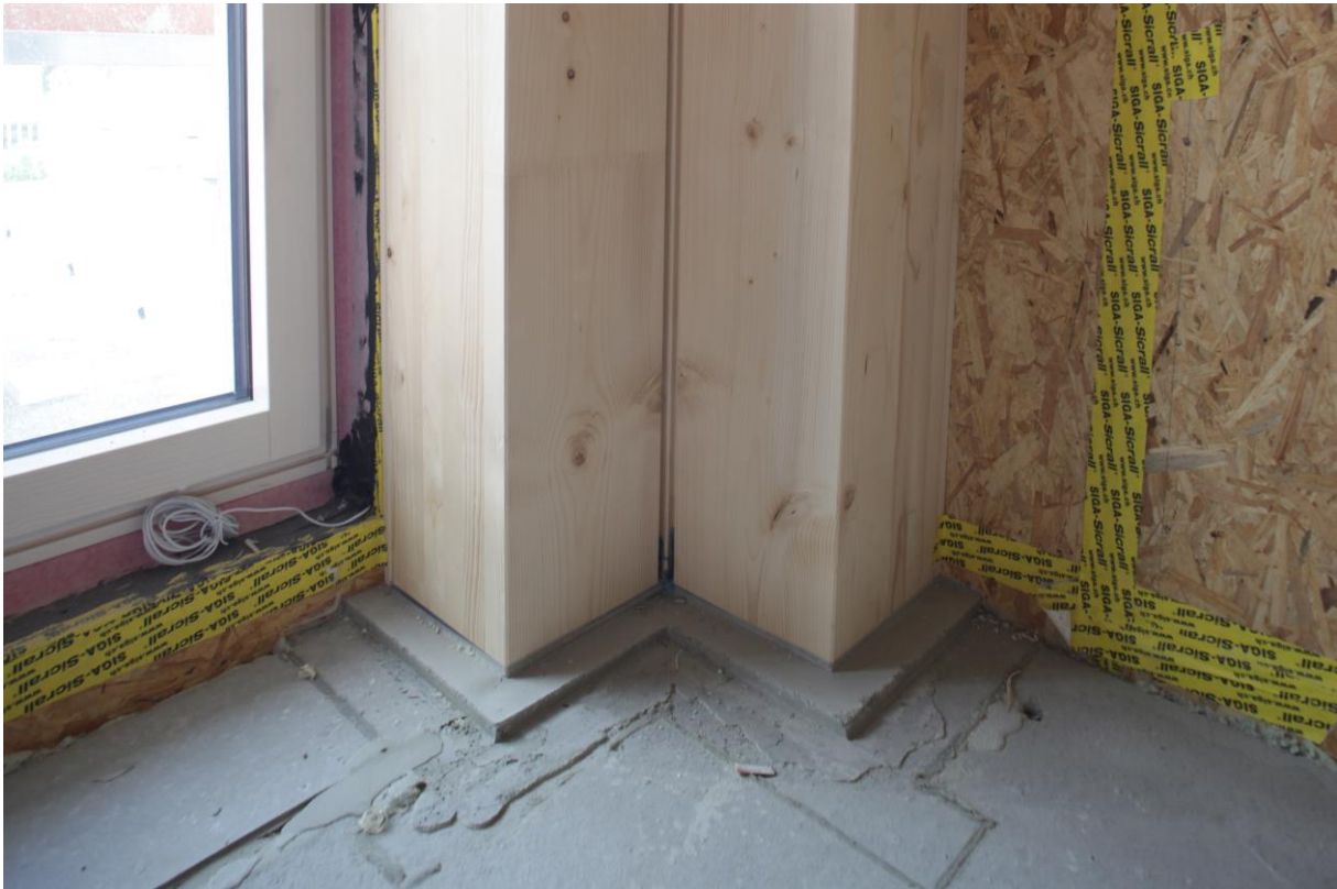
Fensterabdichtung (rosa und schwarz) sowie vertikale und horizontale Abklebung der Element-Stöße
