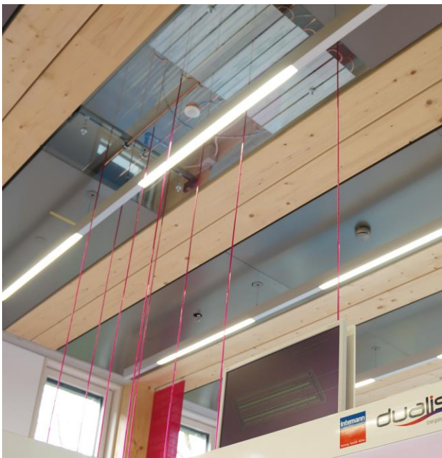
Niedertemperatur-Deckenstrahlplatten
